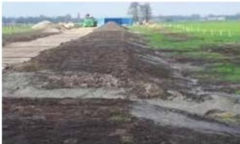
Das letzte weithin sichtbare Zeichen der Erdkabeltrasse ist der ca. 20 bis 30 Meter breite Schutzstreifen, der in Wäldern und Gebüsch eine Schneise zieht. Aus Sicherheitsgründen muss der Schutzstreifen dauerhaft von tiefwurzelnden Gehölzen freigehalten werden.
