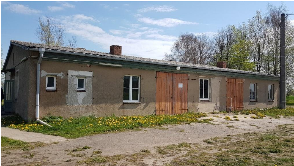
Das ehemalige Grenztruppengebäude in Bitter, Foto: IDD
