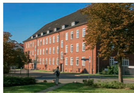
Lüneburg, Behördenzentrum Ost
