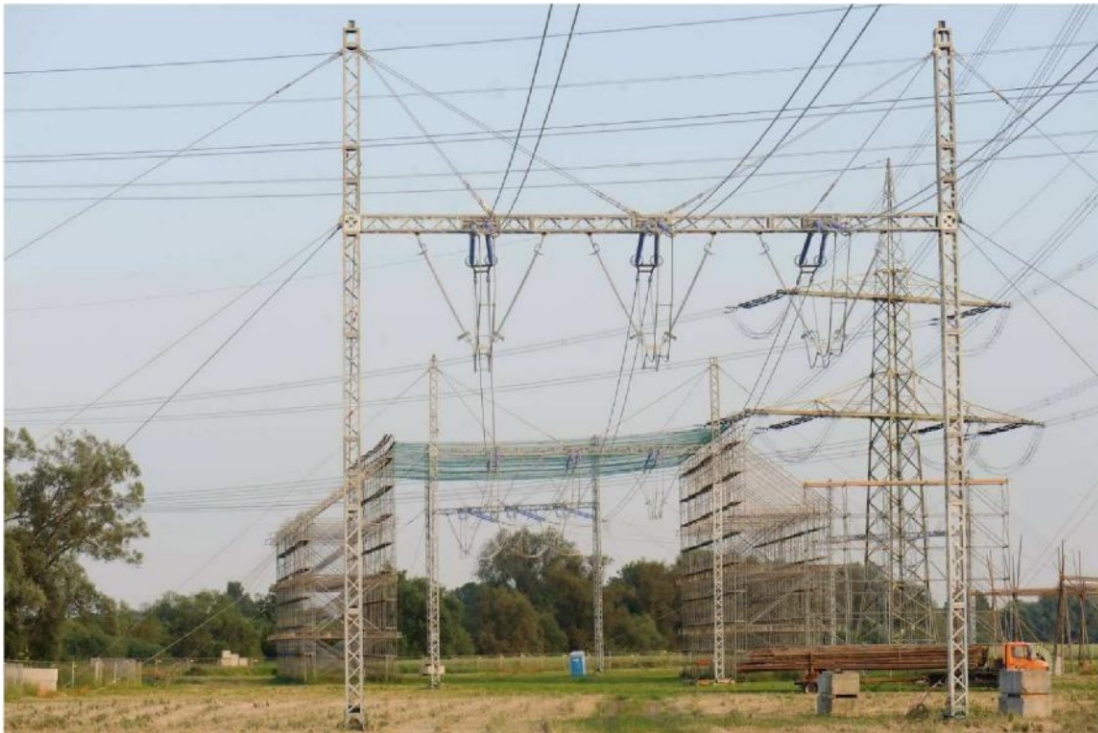
Abb. 6: Einsatz von Provisorien (380-kV-Freileitungsprovisorium für ein System, mit errichtetem Schutzgerüst im Hintergrund)
