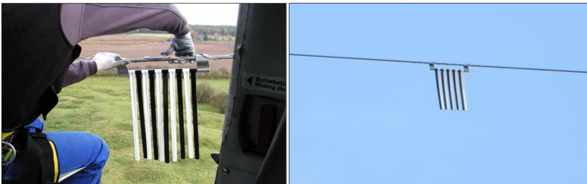
Abbildung 26: Vogelschutzmarker am Erdseil. Dem Stand der Technik entsprechen bewegliche, schwarz-weiße Lamellenmarker.
