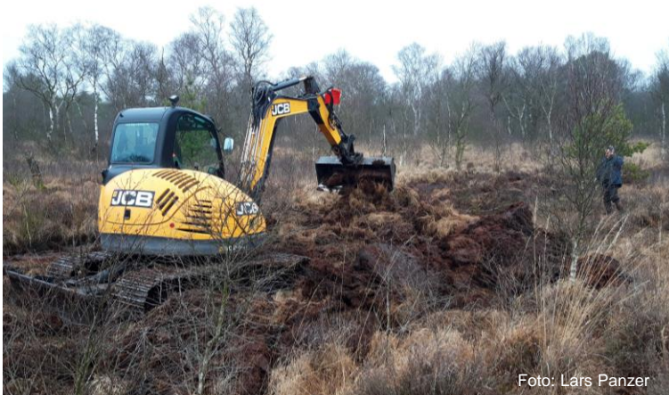
Bagger beim Bauen einer Torfverwallung
